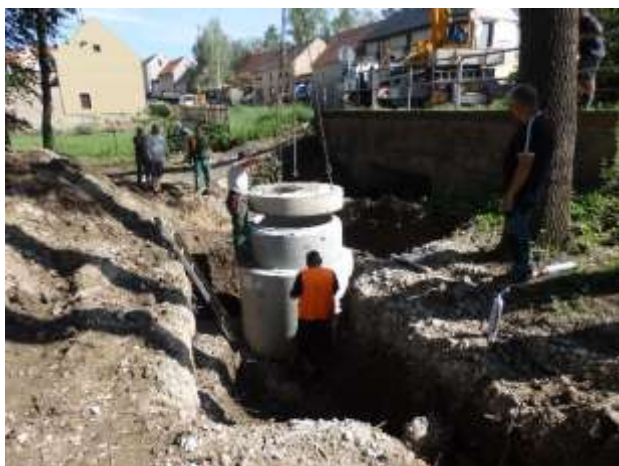
Spouštěna je horní část jímky
