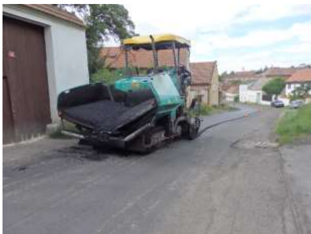
Pokládání povrchu poloviny vozovky
