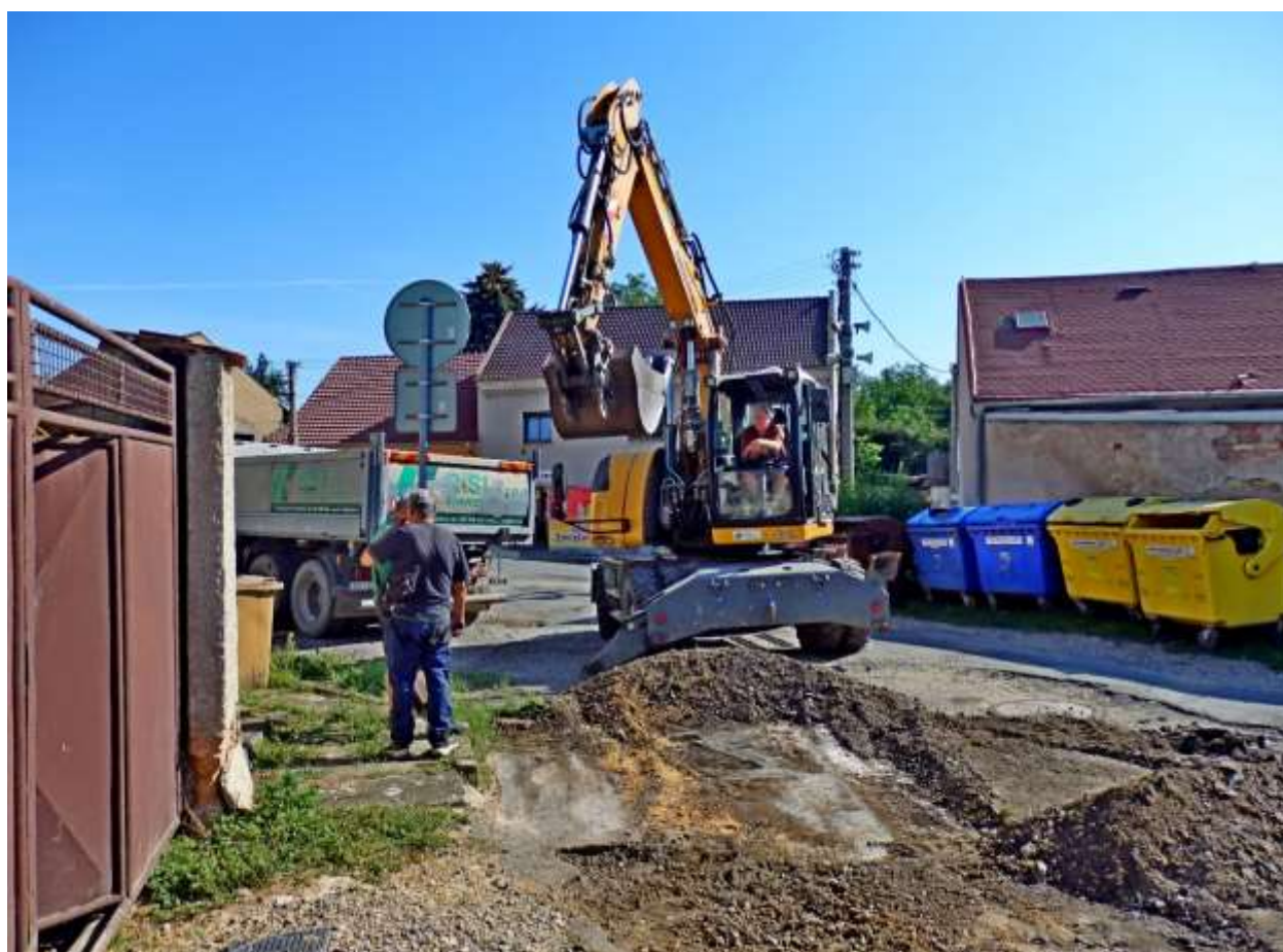
Vyrovňávání silnice Pod Humny
