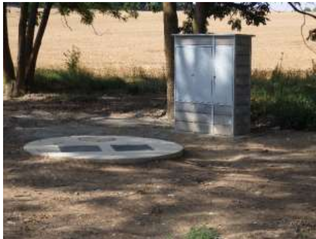
Upravené okolí jímky
